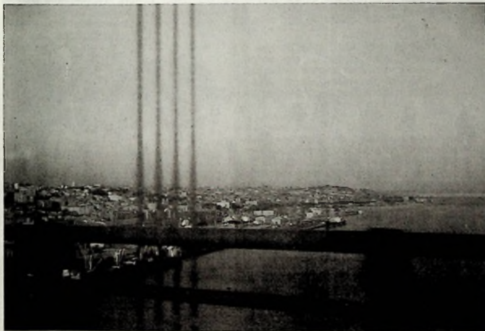
Vue générale du pont suspendu de Lisbonne.
