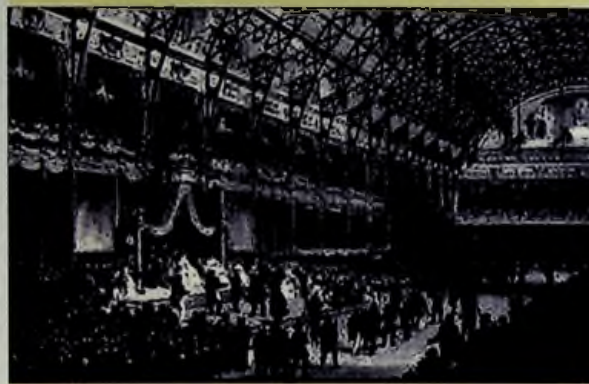
Vue intérieure du Palais de l'Industrie
